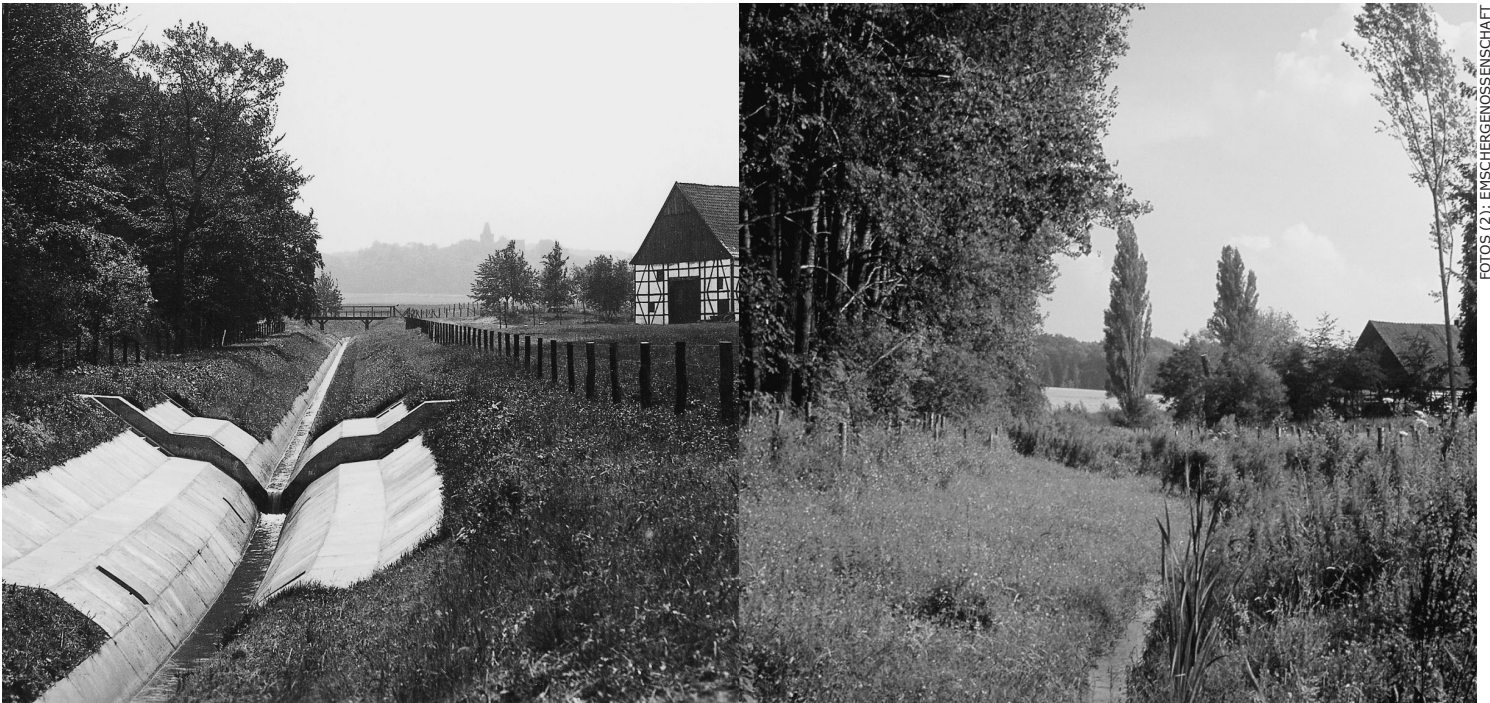
Vor und nach dem Emscher-Umbau: Ansichten vom Emscher-Vorfluter Deininghauser Bach. – Das „Zurück zur Natur“ wirkt auch positiv auf den Arbeitsmarkt.
