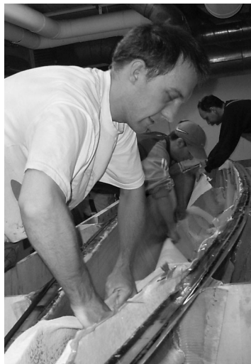
Teamwork: Die Materialien für den ersten Rumpf werden verbaut.
